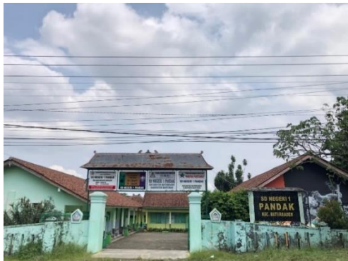
SD NEGERI PANDAK Jalan Raya Baturraden KM. 7
